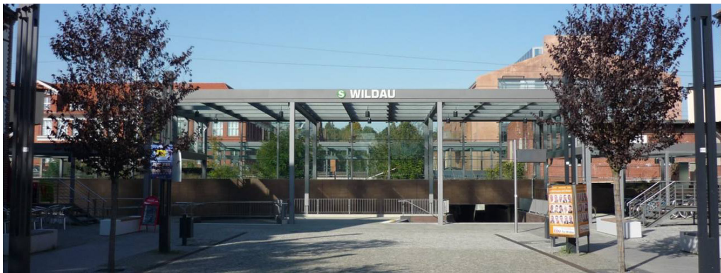
Die denkmalgeschützte Umgebung respektierend und zugleich modern: Zugangsbauwerk am S-Bahnhof Wildau
