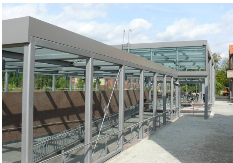
Die überdachte Rampenanlage im „Seitenschiff“ des Zugangsbauwerks
