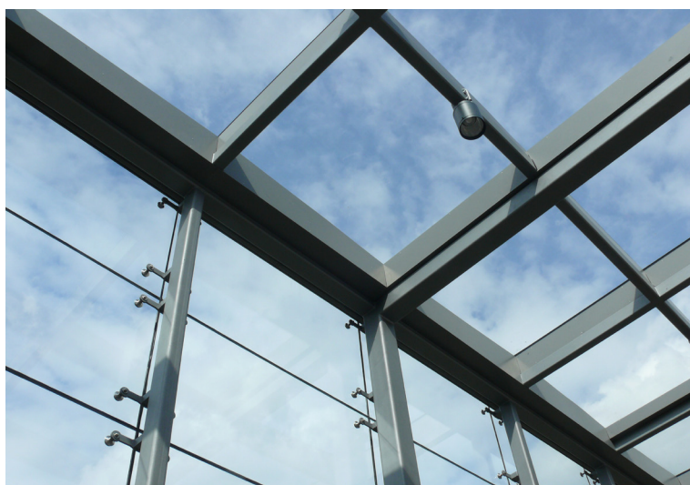
Die großformatigen Glasscheiben wirken leicht und geben dem Bauwerk größtmögliche Transparenz
