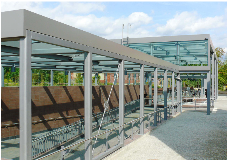
Die überdachte Rampenanlage im ‚Seitenschiff‘ des Zugangsbauwerks
